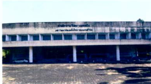
ก่อนการดำเนินงาน
